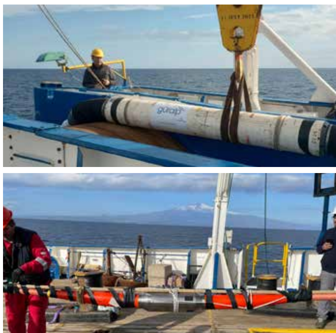
顶部: 正在投放 SMART cable 智能海缆中继器 底部: 正在投放智能海缆仪器吊舱
